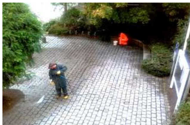
Nach dem Dorfplatz ist jetzt der Rathausvorplatz an der Reihe. Die Bauhofmitarbeiter säuberten zunächst mit einem Hochdruckreiniger die gesamte Fläche, um so die Fugen des Kopfsteinpflasters vorzubereiten. Anschließend wird das Pflaster neu verfugt, um dann wieder auf Dauer sauber und unkrautfrei zu sein.
